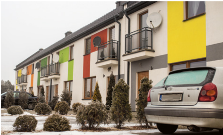
Domki w zabudowie szeregowej w Krobi
