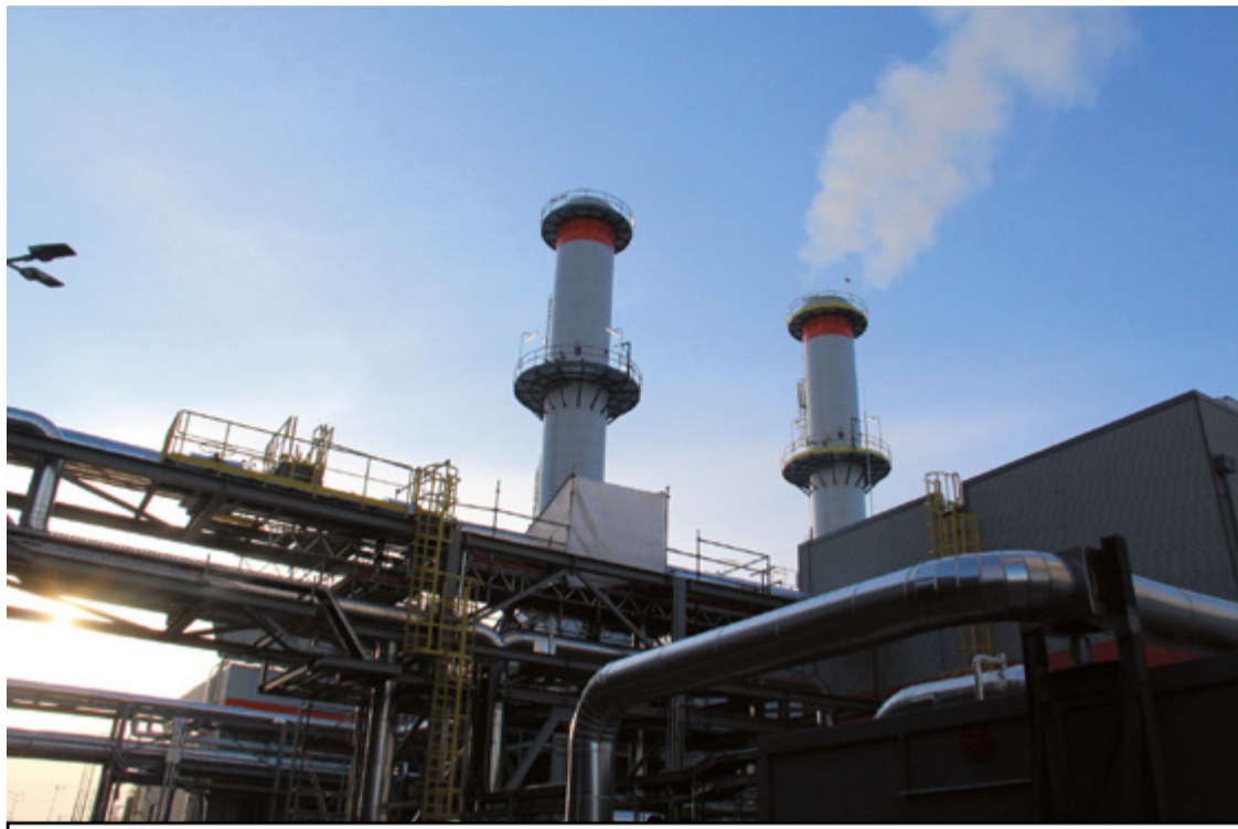
16 grudnia nastąpiło uruchomienie pierwszej turbiny, para z komina kotła odzysknicowego
